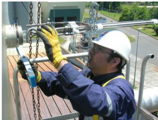
Foto. N°2 Mediciones de Material Particulado en caldera industrial
